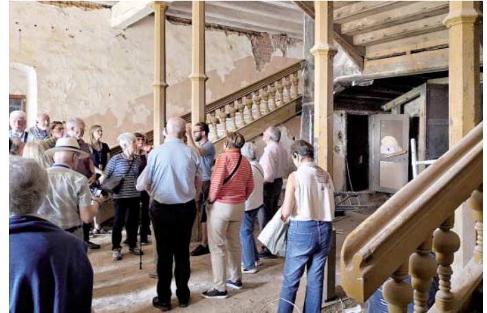
Führung durch die Baustellen im Schlossinneren.
